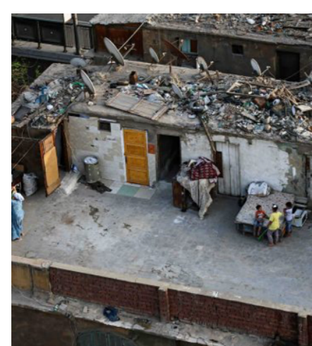
Une vraie vie au-dessus des toits du Caire Source : Urbanité
