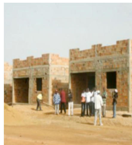
Relance des chantiers logement social à Bamako (photo MaliActu.net)
